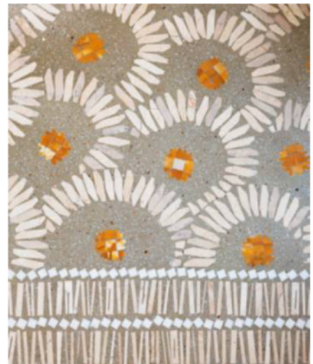
Détail du sol de l'entrée : une mosaïque de marbre en incrustation dans du béton teinté, poncé et poli de Delphine Messmer.
